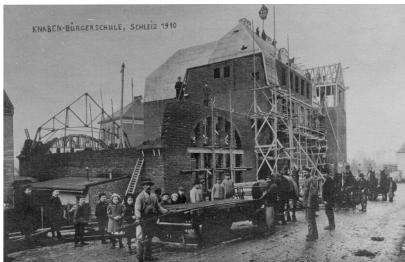
Knabenschule, nach dem Richtfest 1910 von der Kirschkaue Gasse aus fotografiert (Foto: R. Krüger)
